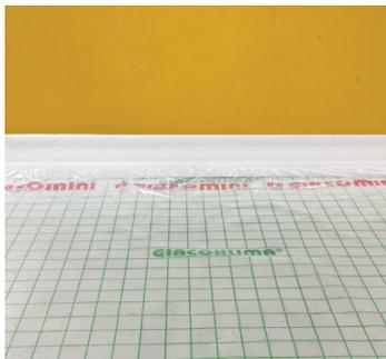
Posa dello strato di protezione in polietilene impermeabile al vapore acqueo su tutta la superficie dell'abitazione.
